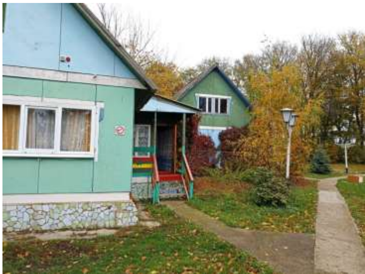
Фото №5 – Вход в жилой корпус
