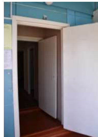
Фото №8 – Дверь в жилом корпусе
