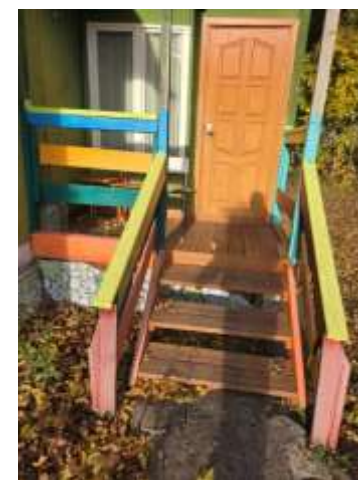
Фото №4 – Вход в жилой корпус
