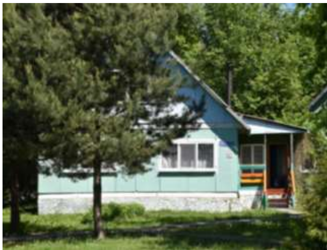
Фото №5 – Вход в жилой корпус
