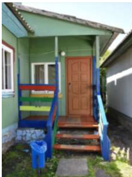
Фото №6 – Вход в медицинский корпус
